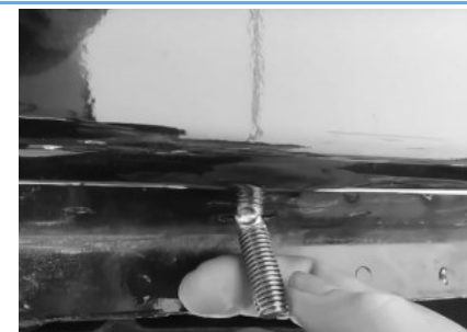
(Fig 3c) Insert (1) M10 J-Bolt
